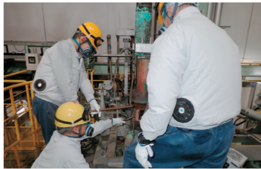
空調服を着用しての作業
